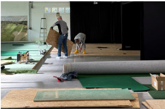
Ralf Ludwig und Friedel Löhr bereiten die Unterbodenkonstruktion des neuen Putting-Grüns vor.
